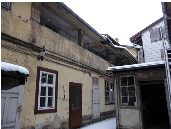
Blick zum Nebengebäude mit Laubengang
